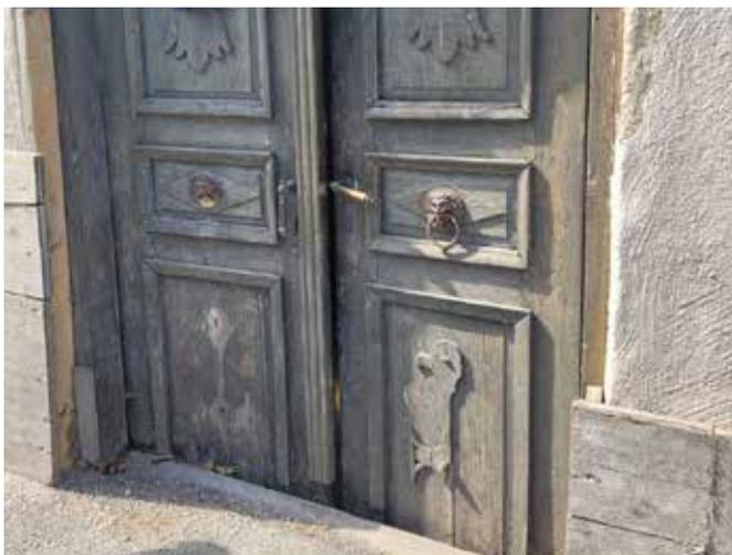
Foto: beschädigte Eingangstür aufgrund langjähriger Regen- und Tauwassereinwirkung.
