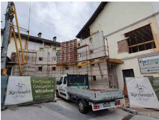
Foto: Die neu betonierte, vorgesetzte Fassade im Südosten
